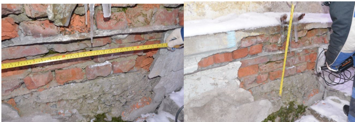
Рис. 12 – Разрушение облицовки цоколя фасада «5/1» в осях «2'2»
