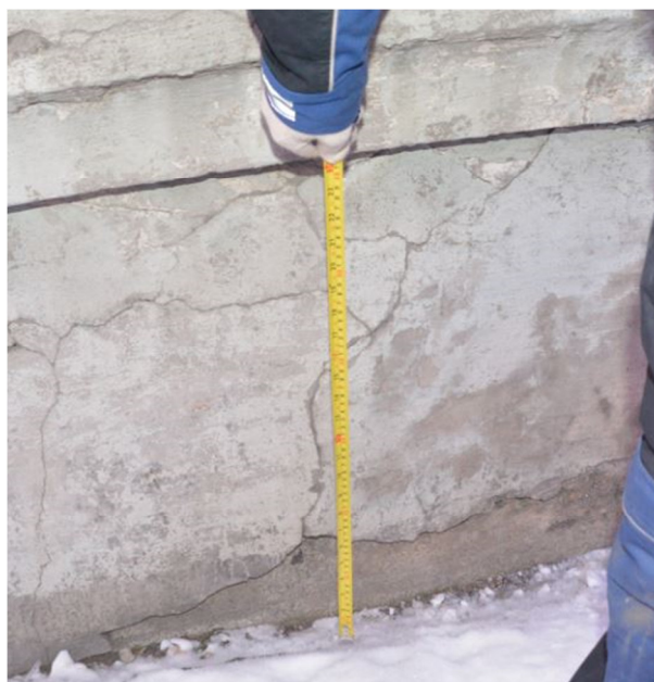
Рис. 14 – Трещины цоколя фасада «5/1» в осях «5/4'»
