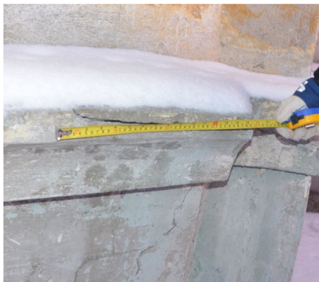
Рис. 18 – Дефект целостности цоколя фасада «1/5» в осях «2/2'»
