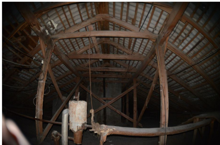
Рис. 22 – Стропильная система
