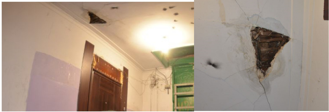
Рис. 21 – Гнилостное поражение балок чердачного перекрытия в осях «2/2'–Д/Е»
