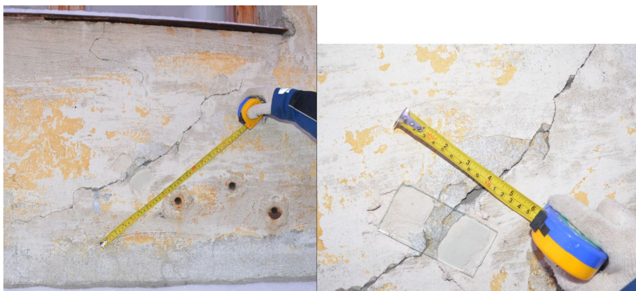
Рис. 20 – Трещина на стене фасада «Ж/А» в осях «Д/Г»
