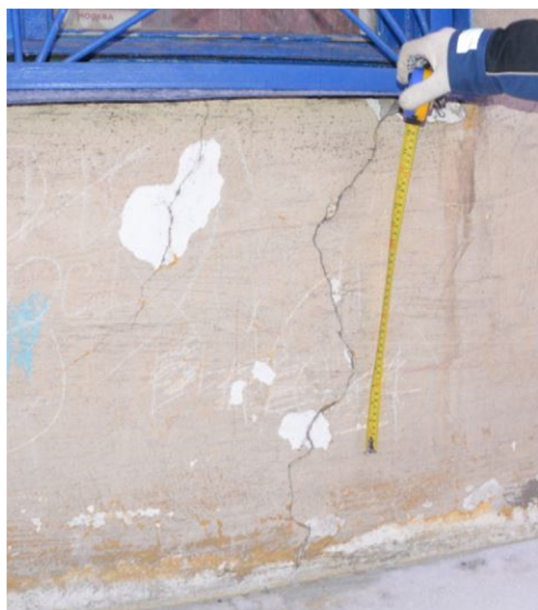
Рис. 17 – Трещины на стене фасада «1/5» в осях «3/4»
