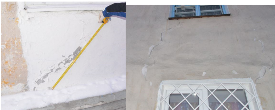
Рис. 16 – Трещины на стене фасада «5/1» в осях «5/4'»
