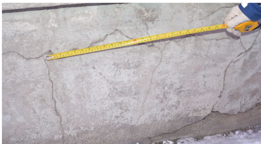
Рис. 15 – Трещины цоколя фасада «5/1» в осях «5/4'»
