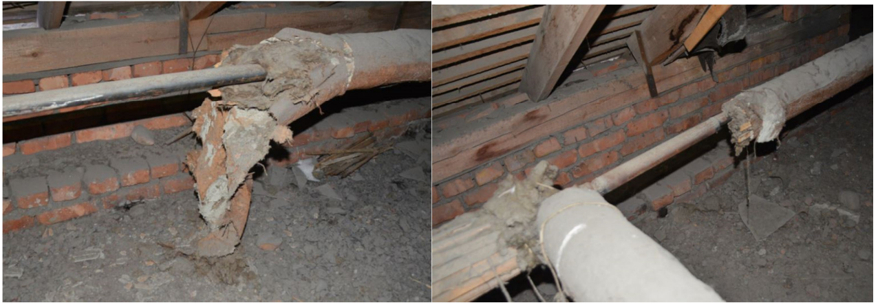
Рис. 26 – Нарушение изоляции труб
