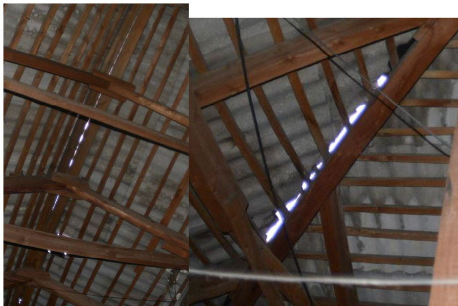
Рис. 25 – Повреждение кровельного покрытия
