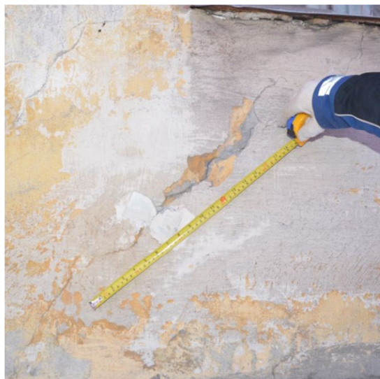
Рис. 19 – Трещина на стене фасада «1/5» в осях «1/2»
