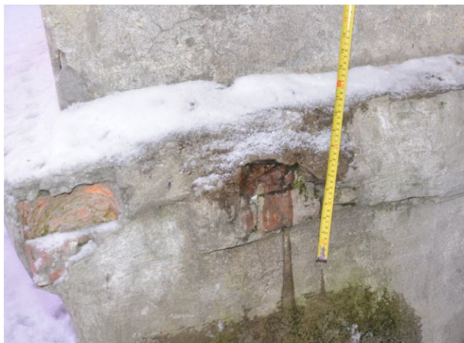
Рис. 13 – Разрушение облицовки цоколя фасада «5/1» в осях «4'4»
