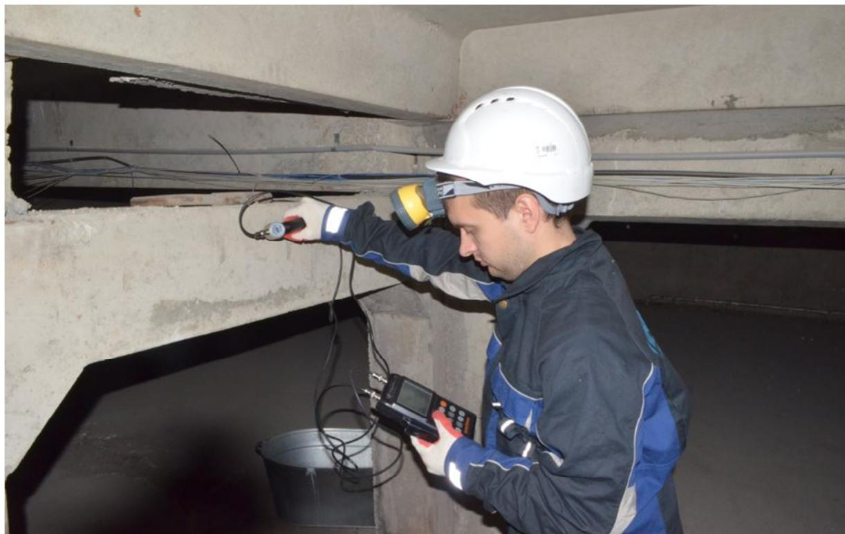
Рис. 11 – Определение прочности бетона стойки чердака СЧ-1
