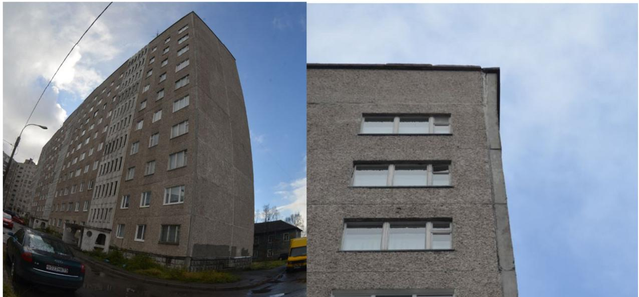
Рис. 2 – Вид на торец секции №1 по оси 1с (визуально выявляется недопустимое отклонение торцевой парапетной панели здания)
