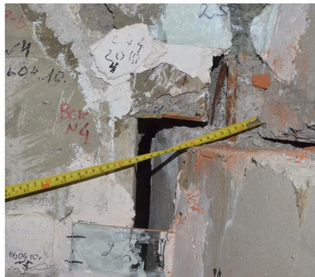
Рис. 17 – Вскрытие узла между стойками чердака СЧ-1 и СЧ-2, секция №1
