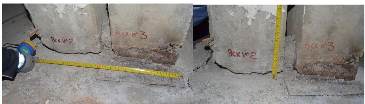
Рис. 16 – Вскрытие опираний стойки СЧ-2 по оси «2с» и стойки СЧ-1 по оси «Дс», секция №1
