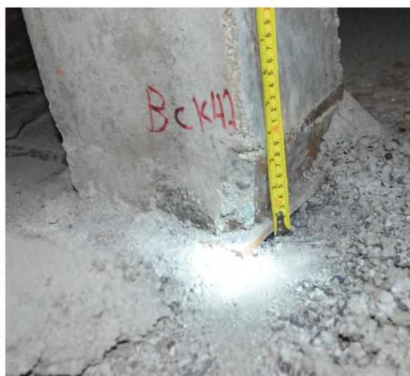
Рис. 18 – Вскрытие опирания стойки СЧ-3 по оси «бс», секция №1
