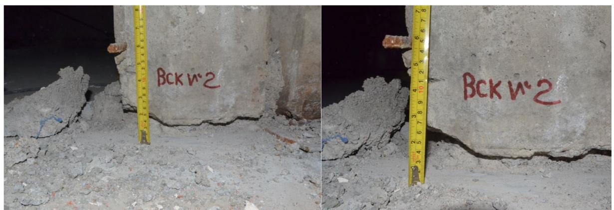
Рис. 15 – Вскрытие опирания стойки СЧ-2 по оси «2с», секция №1
