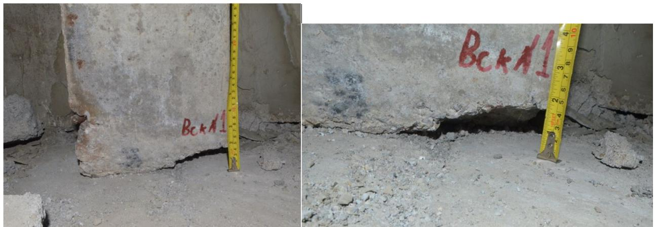
Рис. 14 – Вскрытие опирания стойки СЧ-2 по оси «1с», секция №1
